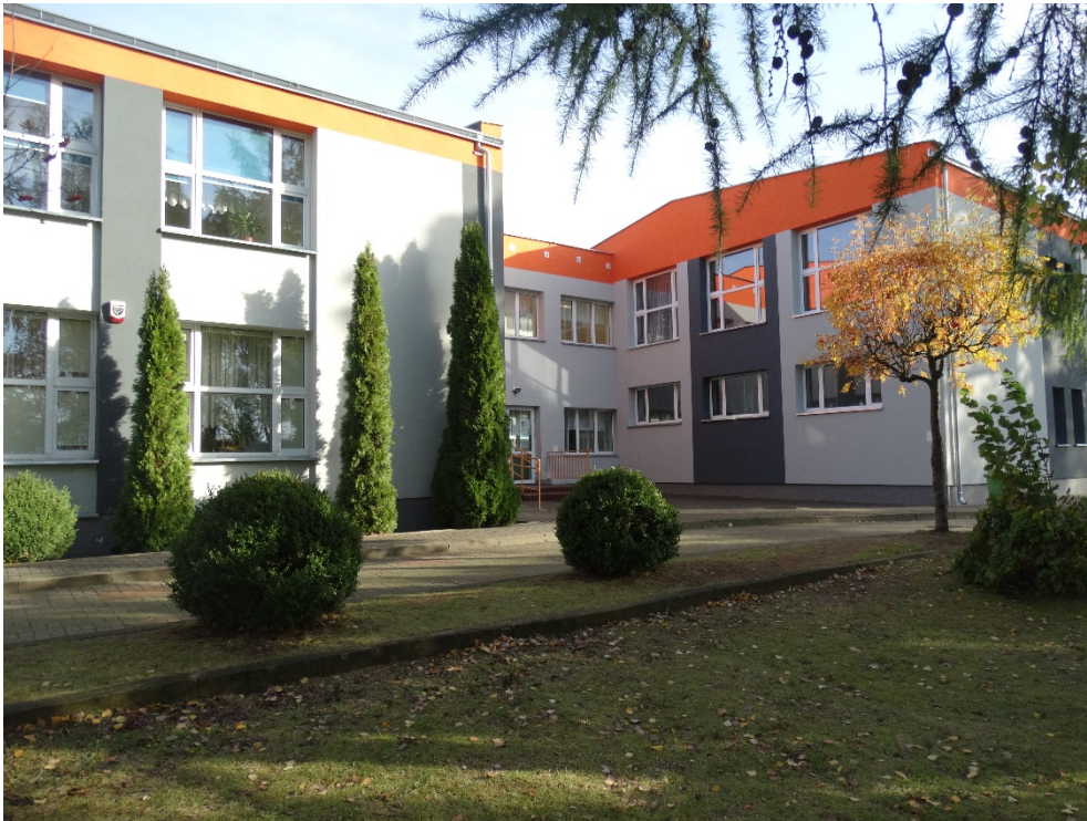
Fot. 6. Termomodernizacja budynku Szkoły Podstawowej w Zegrzu
