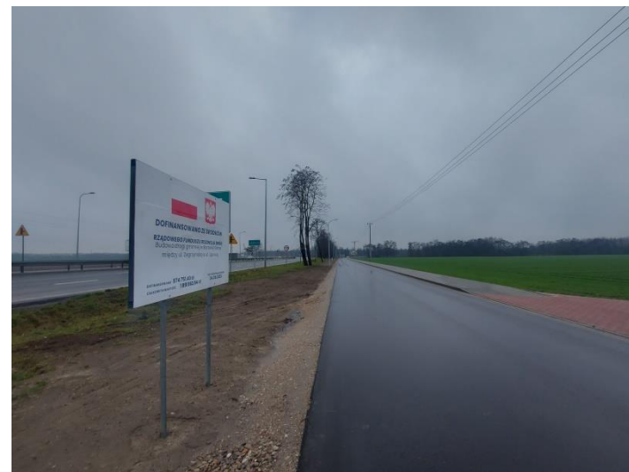
Fot. 4 Budowa drogi w Borowej Górze
